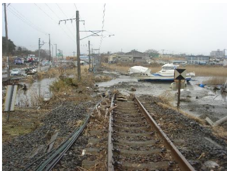
東日本大震災の被災状況（仙石線）
