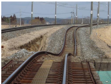
東日本大震災の被災状況（東北本線）
