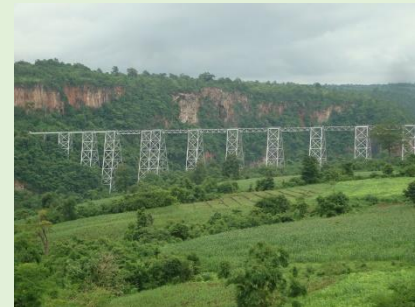
ゴッティ鉄道橋 (ゴッティ駅から)
