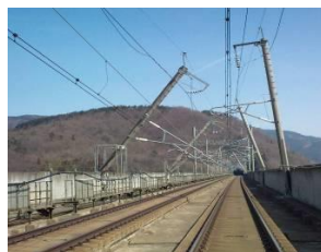
電化柱折損
