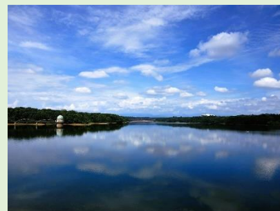
堤体から眺めた村山貯水池
