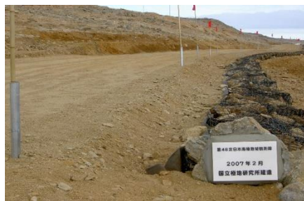
露岩部分を切盛りし完成した輸送用道路
