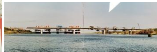
写真② 雄物川最下流の橋梁(秋田県)
