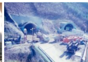
写真⑤ 新中山トンネル(郡山市)
