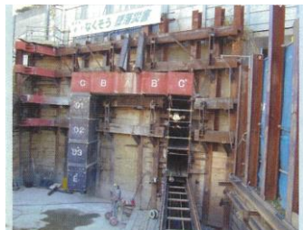
写真⑥ 高速道路下の施工（白河市）
