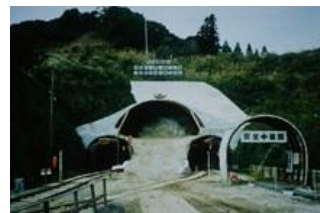
写真③ 舟形トンネル(山形県)
