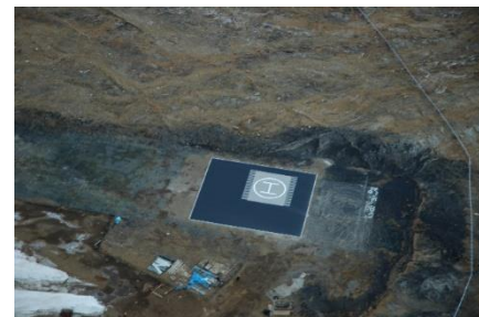
手作業で並べて完成したアルミ製ヘリポート
