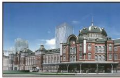
丸の内駅舎復原
