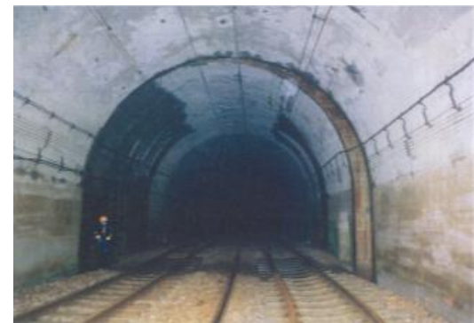
起点方坑口部の雪覆いのずれ 1) に加筆
