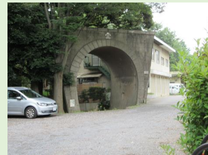
工事演習で建設したトンネル
