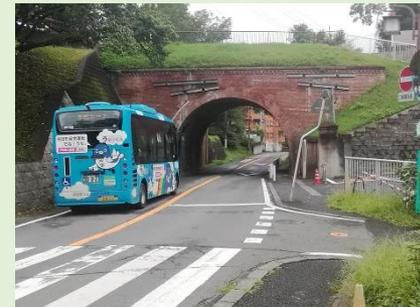
京成成田駅を降りて、右側の緩い坂を下っていくと「電車道」という通りがあります。第二次世界大戦中まで、成田山新勝寺と宗吾霊堂の間を路面電車が走っていたことから、この通りは「電車道」と名付けられたようです。成宗電車第一、第二トンネル(1910年完成)は、この「電車道」の途中にあります。当時の路面電車が使用していた複線断面のレンガ造りのトンネルで、補修の跡を残しながら、現在は道路として使われています。2014年に土木学会の土木遺産に認定されました。
