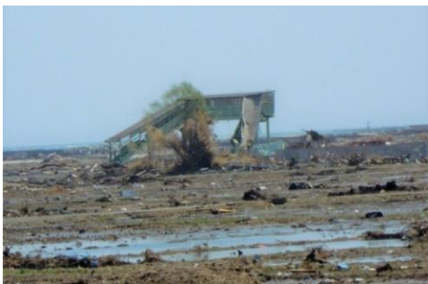
被災した新地駅
