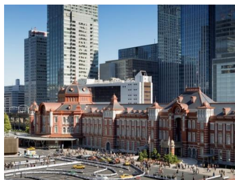
写真 2 東京駅丸の内駅舎保存・復元
