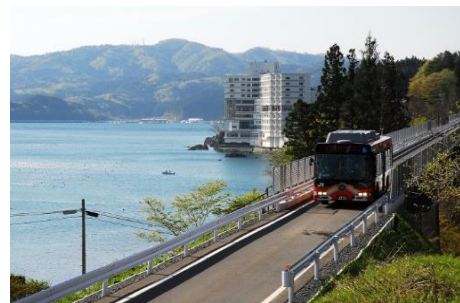
写真 3 BRT による仮復旧
