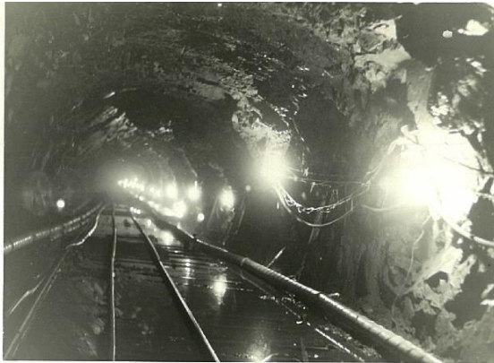
導水路トンネル 山の良い所では無普請で掘削
