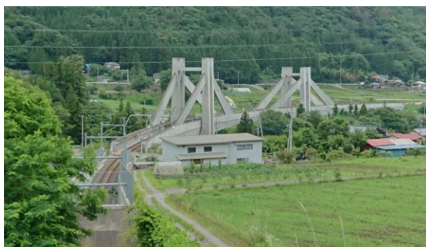
〔第二吾妻川橋りょう〕
