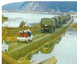
道路兼用河川堤防の復旧(3.14) 暫定1車線で緊急物資輸送
