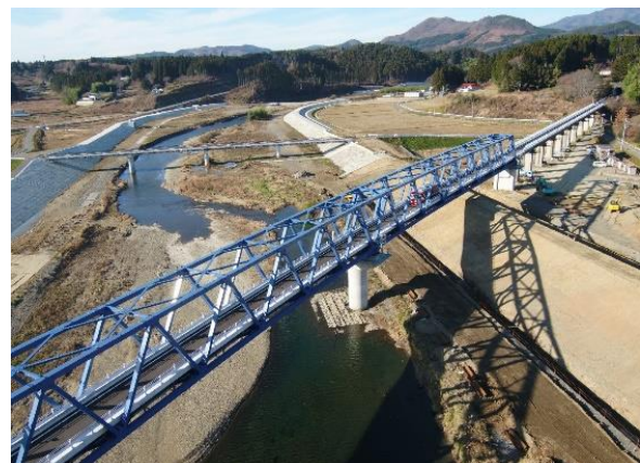
気仙沼線 BRT 津谷川橋りょう
