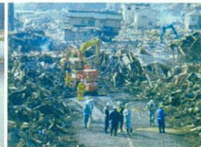
TEC-FORCE・建設業者等による 道路啓開(宮城県気仙沼市)
