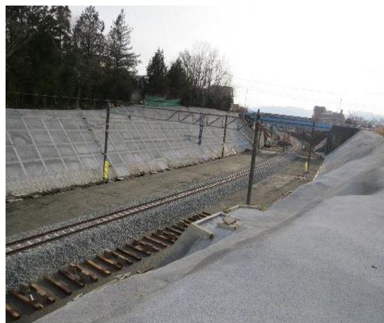
モルタル吹付（夜ノ森～大野）
