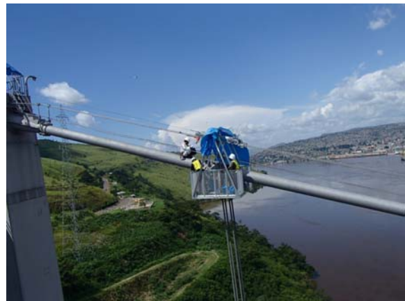
ケーブル錆防止システム設置工事 (IHI インフラストラクチャーシステム)
