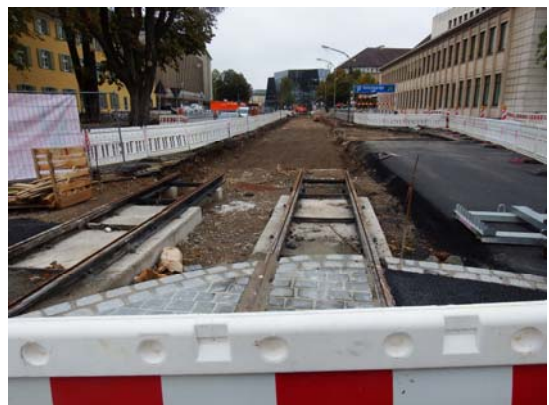
写真2 LRTの工事現場
