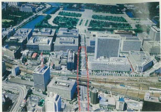
工事着手前全景（航空写真）
