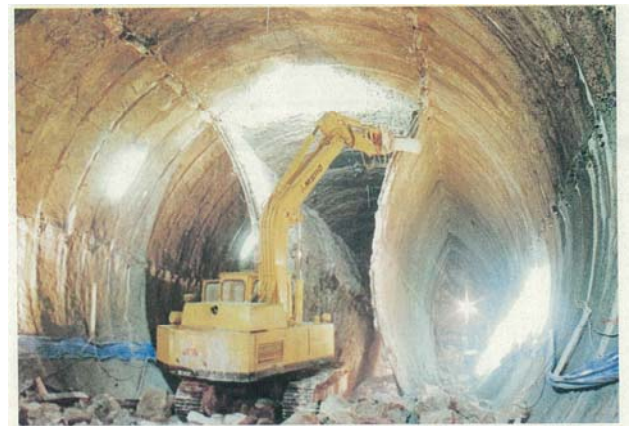
東京駅前で大断面 NATM 工法
