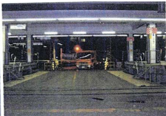
昇降式ホーム(降下時)
