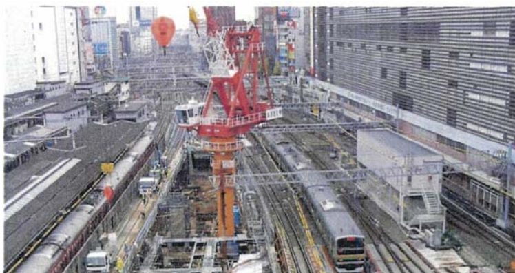
タワークレーン 2 基による鉄骨架設
