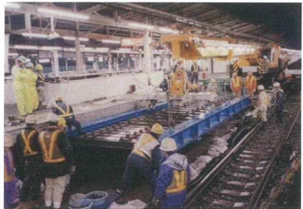
工事桁架設状況
