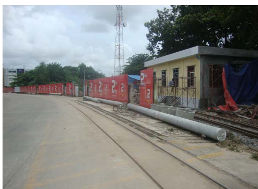
電柱建植直前の状況
