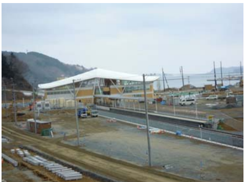
山側から望む女川駅 石巻線浦宿・女川間は、 2015年3月21日営業再開予定。
