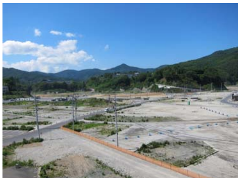
被災後、倒壊家屋等撤去後の女川 地区
