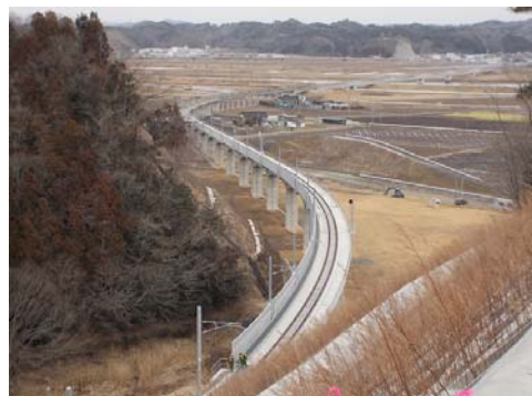
野蒜駅終点方の切取部から石巻 方を望む。高架橋形式で既設の鳴 瀬川橋りょうへ接続する。
