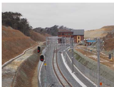
石巻方から野蒜駅を望む。 周囲はUR都市機構による基盤整備事業。
