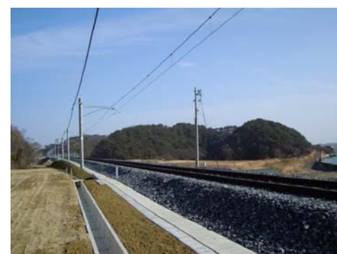
右側の堤防沿いの旧線路敷に替わり新しい街となる高台地区への別線付け替えが行われた。 2015年5月30日供用開始予定。
